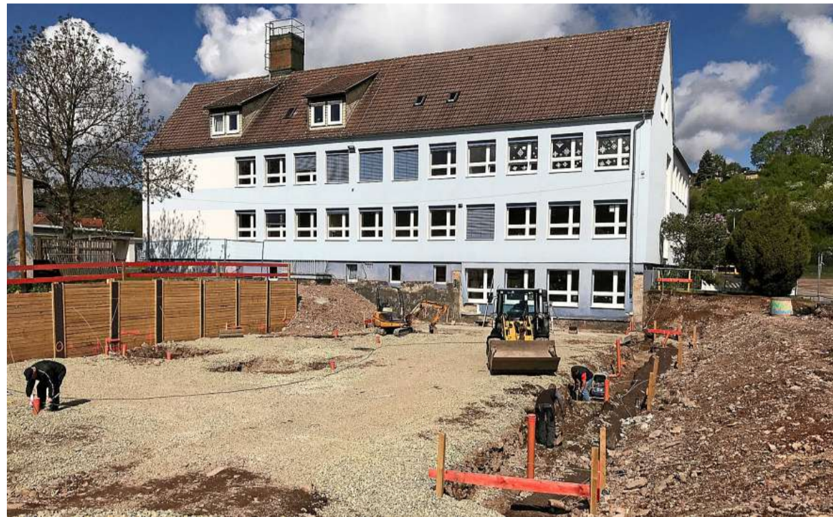
Die Bauarbeiten für den Anbau ans Hauptgebäude der Regelschule in Geraberg haben im März begonnen.
